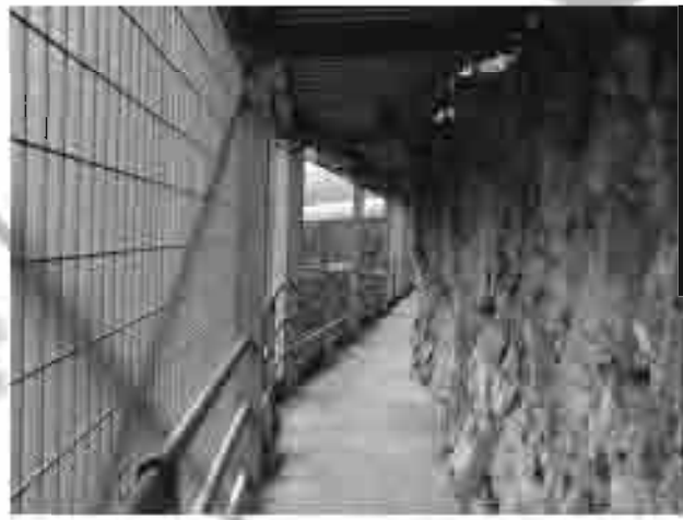
percorso coperto percorso esistente che conduce a coronamento della diga
