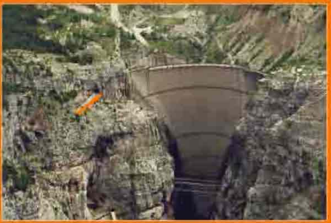
Il varco tra le due gallerie è uno scorcio diretto sulla diga e sull'altipiano sottostante. Per una migliore fruizione e valorizzazione del coro Visuale, si propone una struttura metallica e d'acciaio (m 1,5) dello spazio roccioso, sostenuta da puntori a mensola.
