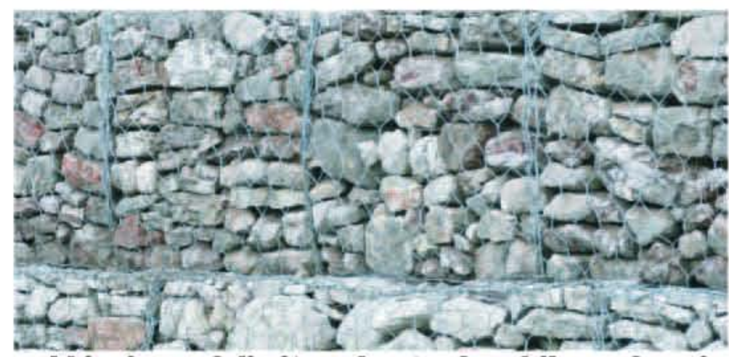
gabioni per delimitare la strada ed il parcheggio
