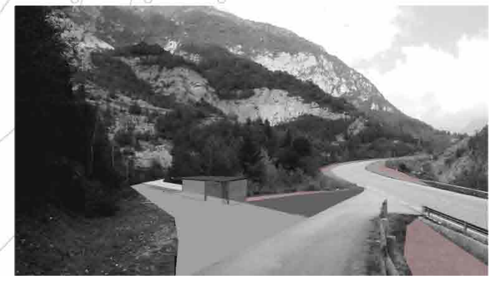
vista 3_area parcheggio A l'area parcheggio A sfruttando la depressione esistente diventa quasi invisibile dalla strada statale se non nel punto d'ingresso dove vi è il presidio per il nodo d'interscambio
